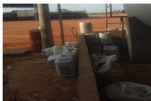
Figura 6: Bacia de Contenção do posto de combustível da Fazenda 3
